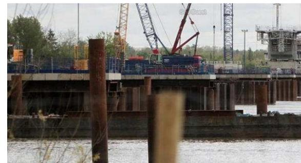
Photographie 16 : Exemple d'estacade - chantier LGV Bordeaux
